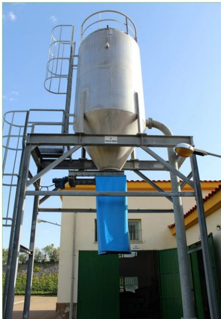
Tolva de lodos deshidratados de EDARU Aceuchal (Badajoz)
